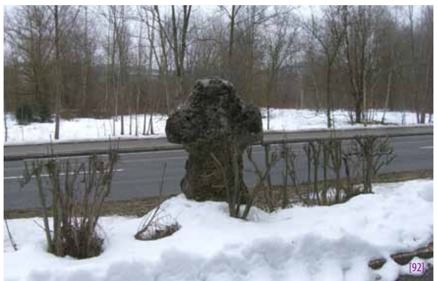
Im Jahre 2006 ist das Kreuz stark verwittert und von Umwelteinflüssen belastet.
